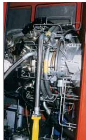
Turbogas 2008 - Per produzione di energia elettrica e termica; combustibile: metano.
