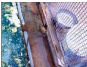
All'interno del canile le condotte di raccolta dei liquami sono aperte, e anche in questo caso, soprattutto nell'ipotesi di eccessive emissioni o precipitazioni atmosferiche, possono anche in questo caso verificarsi episodi di dispersione delle acque reflue.
