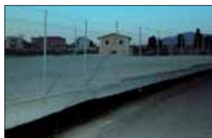
Il cantiere sequestrato.
