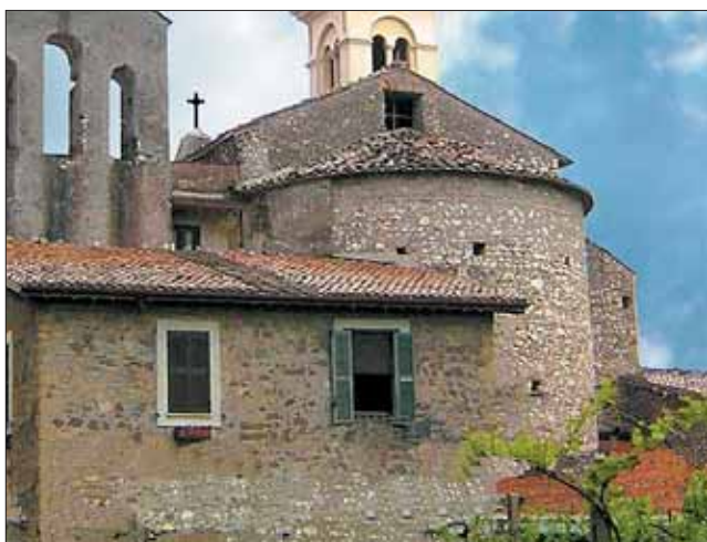
Particolare del tetto dell'abside.
