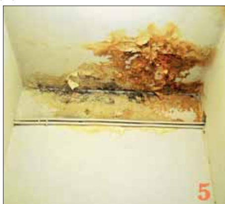
1 - L'impalcatura pericolosa e cadente da qualche anno si trova allestita e vorremmo capire l'utilità nel tenerla montata da circa 4 anni; 2 e 3 - L'umidità della parete esterna trasmessa alla parete interna; 4, 5 e 6 - L'umidità nei soffitti: sono evidenti e visibili le macchie lasciate dall'acqua piovana.
