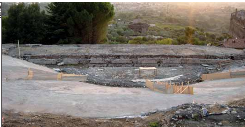
Le foto si riferiscono ai lavori di ripristino delle strutture all'interno del santuario.
