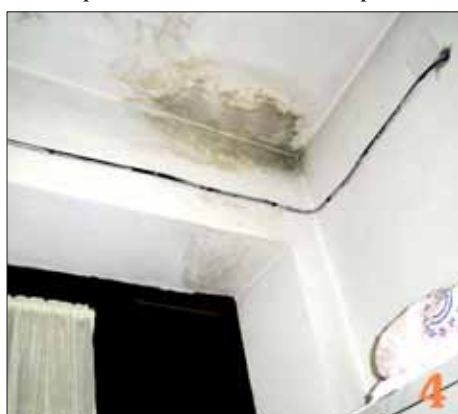
1 - L'impalcatura pericolosa e cadente da qualche anno si trova allestita e vorremmo capire l'utilità nel tenerla montata da circa 4 anni; 2 e 3 - L'umidità della parete esterna trasmessa alla parete interna; 4, 5 e 6 - L'umidità nei soffitti: sono evidenti e visibili le macchie lasciate dall'acqua piovana.
