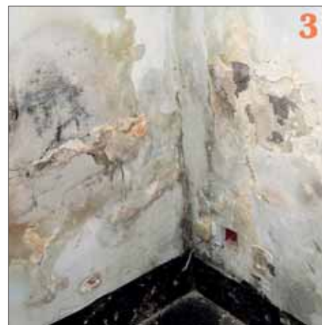
1 - L'impalcatura pericolosa e cadente da qualche anno si trova allestita e vorremmo capire l'utilità nel tenerla montata da circa 4 anni; 2 e 3 - L'umidità della parete esterna trasmessa alla parete interna; 4, 5 e 6 - L'umidità nei soffitti: sono evidenti e visibili le macchie lasciate dall'acqua piovana.
