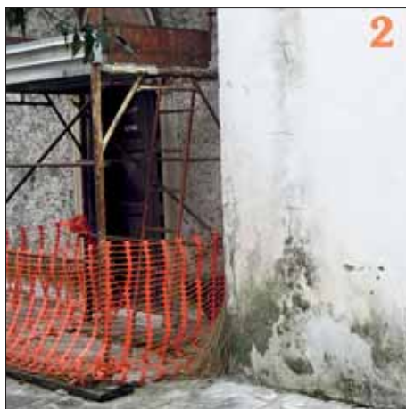
1 - L'impalcatura pericolosa e cadente da qualche anno si trova allestita e vorremmo capire l'utilità nel tenerla montata da circa 4 anni; 2 e 3 - L'umidità della parete esterna trasmessa alla parete interna; 4, 5 e 6 - L'umidità nei soffitti: sono evidenti e visibili le macchie lasciate dall'acqua piovana.
