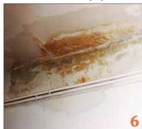
1 - L'impalcatura pericolosa e cadente da qualche anno si trova allestita e vorremmo capire l'utilità nel tenerla montata da circa 4 anni; 2 e 3 - L'umidità della parete esterna trasmessa alla parete interna; 4, 5 e 6 - L'umidità nei soffitti: sono evidenti e visibili le macchie lasciate dall'acqua piovana.
